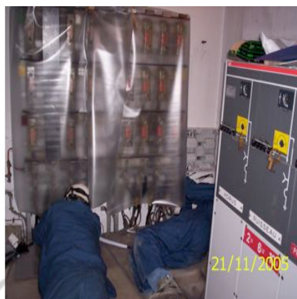
Installation d'un injecteur CPL et couplage basse tension
